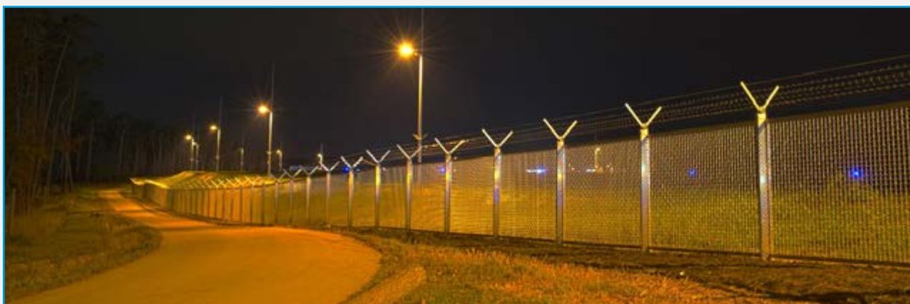
Fig. 2 : un grillage de sécurité à l'aéroport de Francfort avec éclairage artificiel. (Photo crédit: Norbert Nagel)
